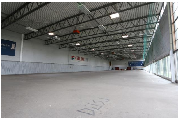
Her sees dagens messehall A i Tønsberg som i løpet av et år blir bygd om til moderne idrettsanlegg – blant annet basishall! Foto: Kristoffer Husebæk
